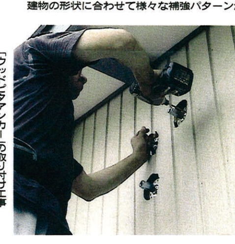
「ウッドピタ」の取り付け作業
